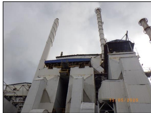
รูปที่ 2-4 ปล่องระบายอากาศของโครงการ
