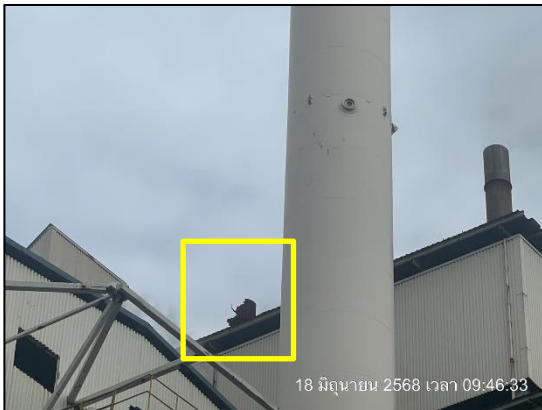
รูปที่ 2-8 Silencer บริเวณ Valve ท่อส่งไอน้ำ
